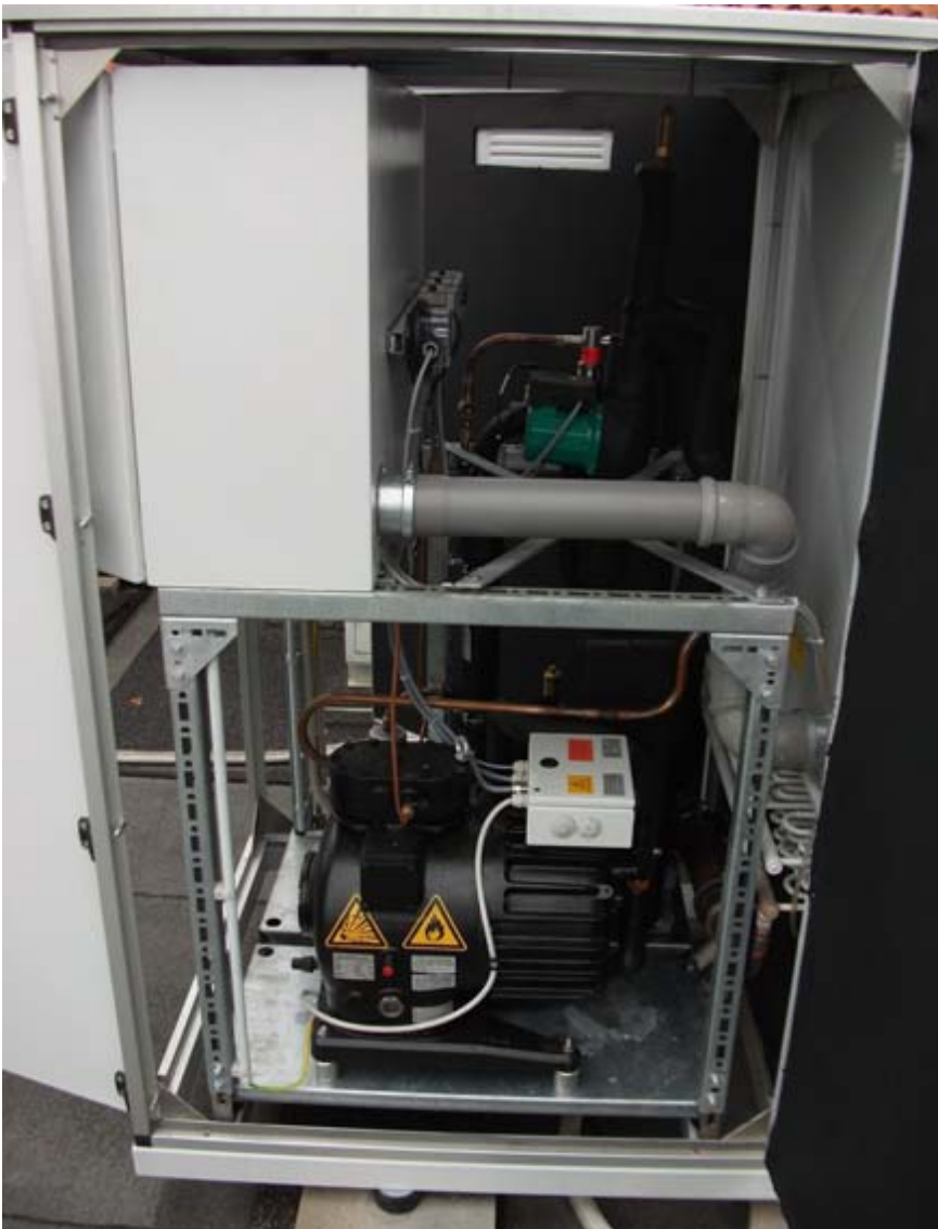
Bild 4: Der Schaltkasten wird extern belüftet
