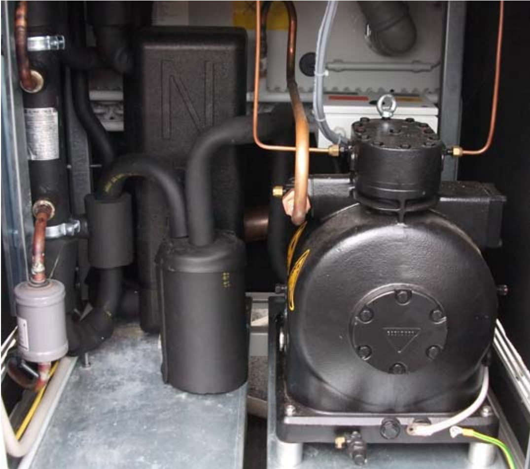
Bild 3: Einblick in das Innere des Gehäuses: Verdichter, Verdampfer, Sauggaswärmetauscher, Flüssigkeitsabscheider sowie Filtertrockner und Schauglas sind platzsparend, jedoch gut zugänglich angeordnet.
